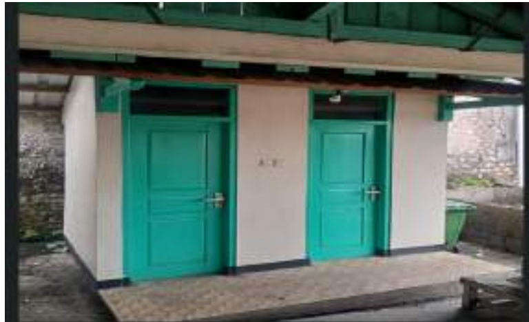
Gambar III.20 Pembangunan mck Pasar Karangtengah
