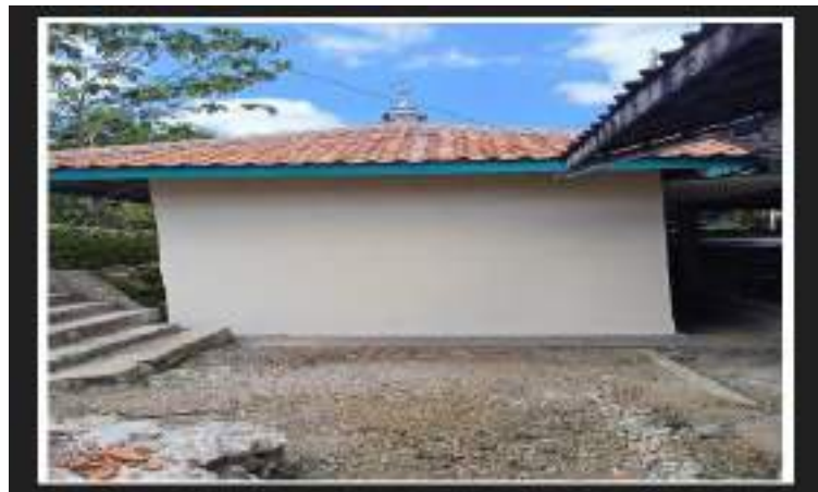
Gambar III.18 Pembangunan musholla Pasar Bedoyo
