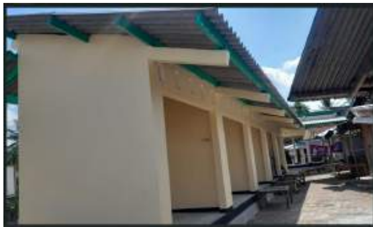
Gambar III.21 Pembangunan kios Pasar Ngalang
