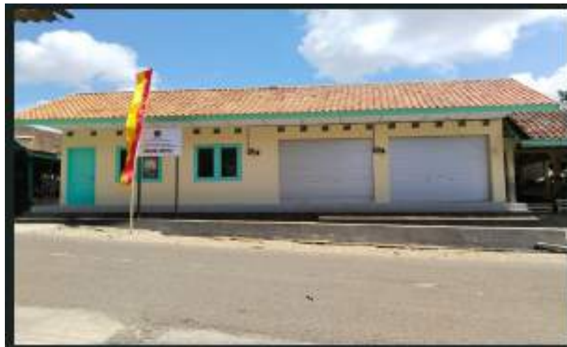
Gambar III.24 Pembangunan kios dan kantor pasar Pasar Jepitu
