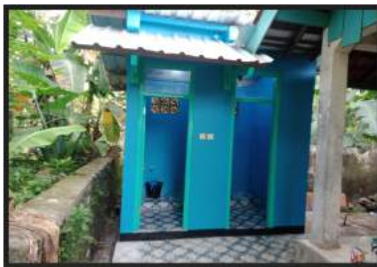
Gambar III.19 Pembangunan mck Pasar Sambeng
