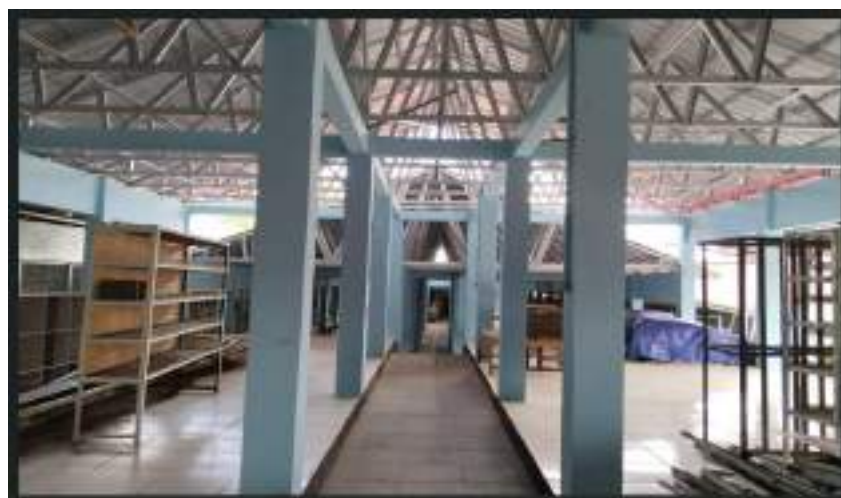
Gambar III.25 Rehab los dan kios Pasar Trowono
